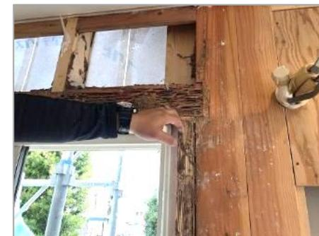
【腐朽菌の被害】
